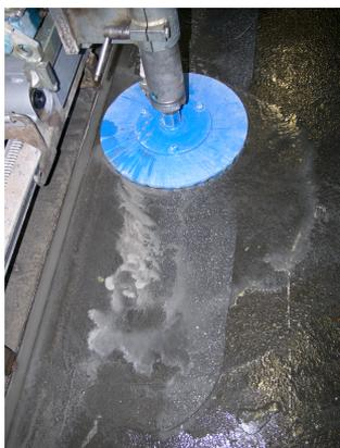
**Die Problemstellung:** Der Hallenboden im Bereich der Hebebockstandflächen ist nicht 100% eben. Die Hebeböcke stehen nicht sicher und drohen auf die Züge zu kippen.
